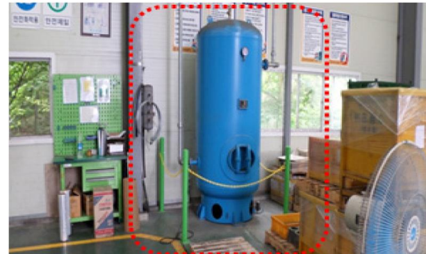
압력용기 주변 안전체인 설치
