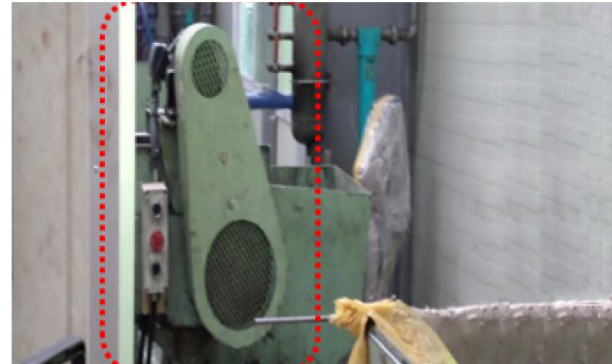
컨베이어 구동체인 방호커버 설치
