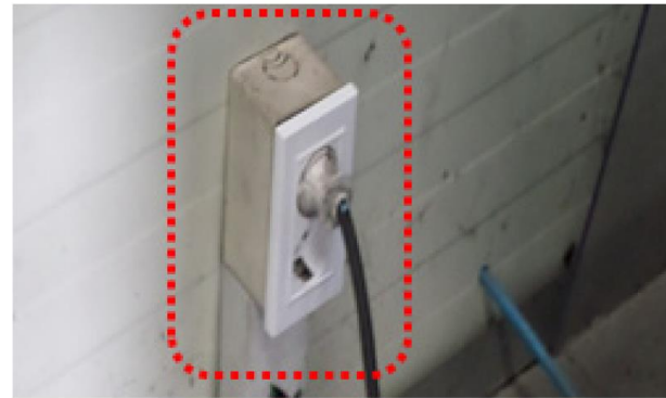
압력용기 후면 콘센트 재설치
