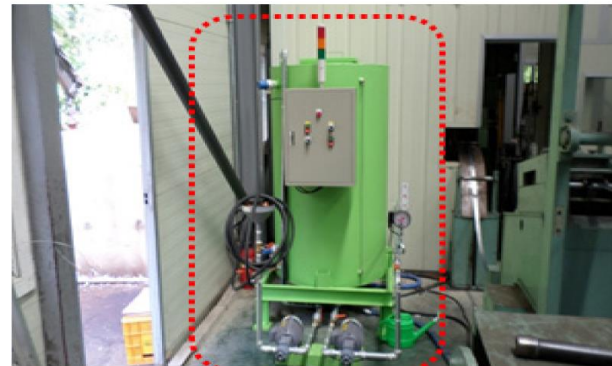
프레스 타발유 자동공급장치 및 배관 설치
